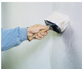
Грунтовка гипсокартона
