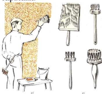
Рис. 5. Отделка поверхности наборными торцовками: а — техника отделки наборными торцовками, б — наборные торцовки
