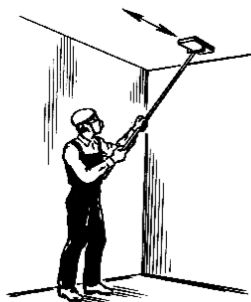
Рис.4. Сглаживание поверхности шарнирной теркой
